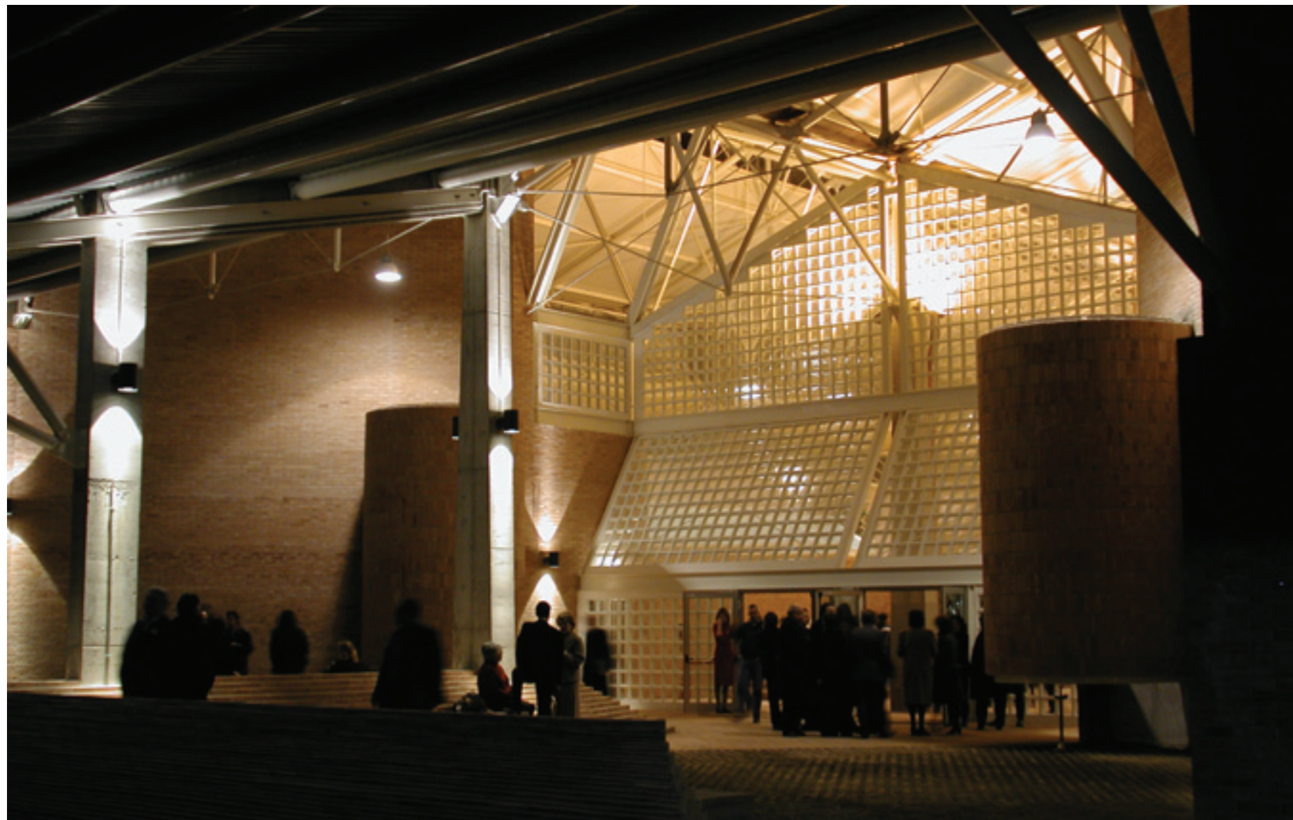
■ In copertina: La galleria centrale con uno degli ■ specchi d'acqua in cui si rispecchiano le ■ controventature centrali ■ In alto: La testata sud del B.I.C. ■
