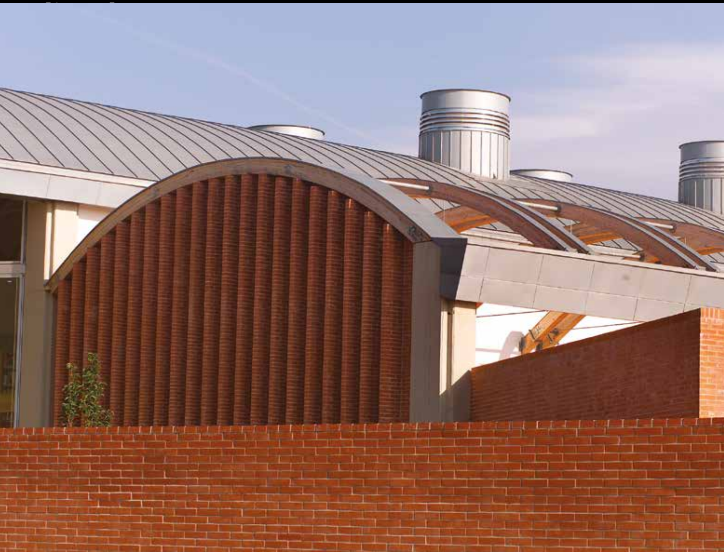
11 Detail of the south front, in the roof the air and light chimneys / Dettaglio del fronte sud, in copertura i camini d'aria e di luce.
